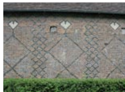
Appareil de briques polychromes posées en boutisses et en carreaux.
