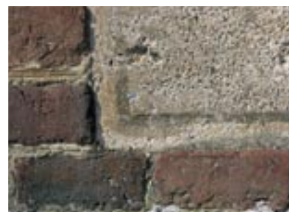
Au XIX e siècle, un filet noir en creux souligne les encadrements de baies et les chaînes d'angle
