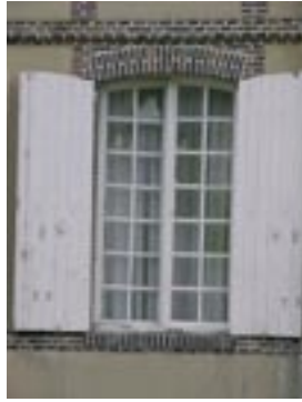
Volets pleins : assemblage à lames
